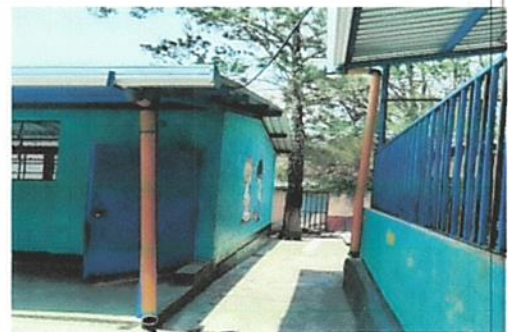
Foto 6: Sustitución de bajadas de agua pluvial.
