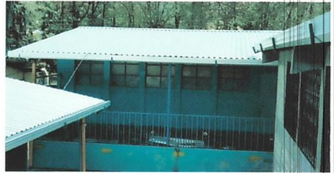
Foto 2: Techo de aula No. 1 y 2, y corredor sustituido por lámina troquelada
