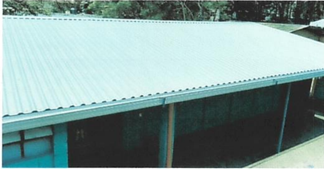
Foto 1: Techo de Aula No. 4 y corredor, sustituido por lámina troquelada
