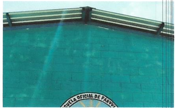
Foto 4: Mantenimiento a estructura de techo tipo costanera.
