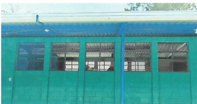
Foto 5: Sustitución de canales.
